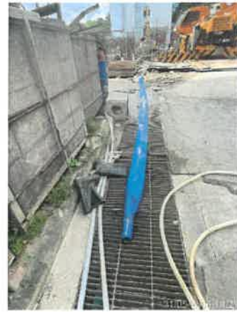
รูปที่ 2-5 แสดงการติดตั้งท่อระบายน้ำ และเครื่องสูบน้ำ สำหรับรวบรวมน้ำเข้าสู่บ่อพัก
