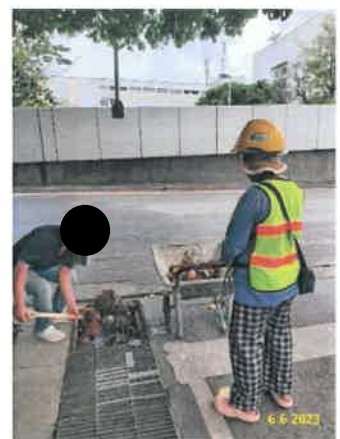
รูปที่ 2-31 แสดงเจ้าหน้าที่ทำความสะอาดรางระบายน้ำ บ่อดักตะกอนภายในพื้นที่โครงการ และบริเวณรางระบายน้ำริมถนนสาธารณะด้านหน้าโครงการ
