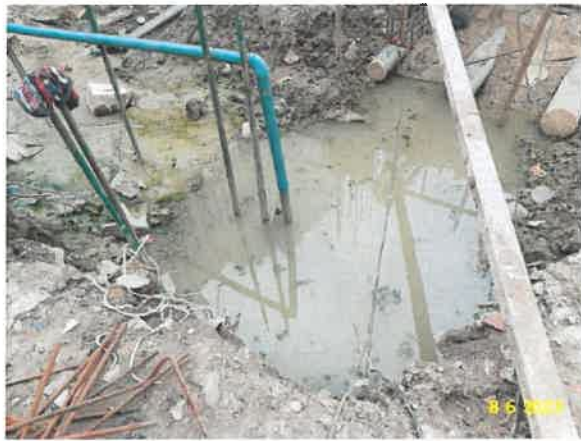
รูปที่ 2-5 แสดงการติดตั้งท่อระบายน้ำ และเครื่องสูบน้ำ สำหรับรวบรวมน้ำเข้าสู่บ่อพัก
