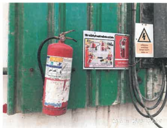
รูปที่ 2-63 แสดงถังดับเพลิงชนิดผงเคมีแห้ง พร้อมป้ายแนะนำการใช้งาน
