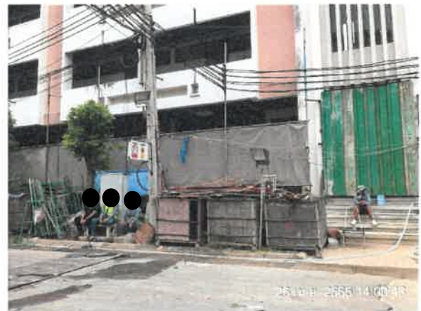
รูปที่ 2-15 แสดงกล่องไม้ที่ปิดล้อมทั้ง 4 ด้าน ไว้สำหรับเก็บเศษวัสดุก่อสร้าง
