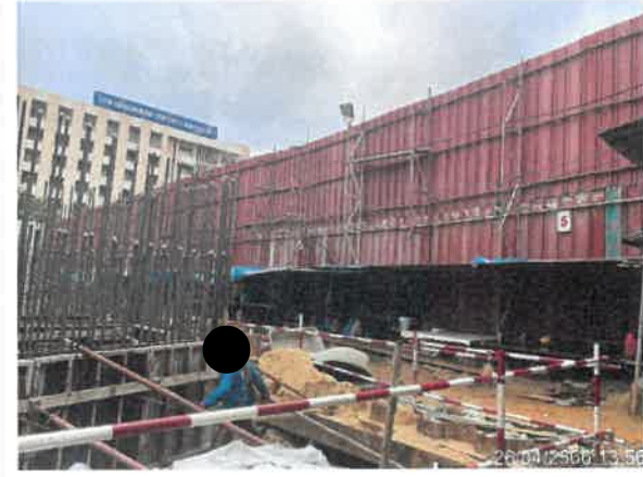
รูปที่ 2-2 แสดงรั้วทึบเมทัลชีท (Metal Sheet) รอบพื้นที่ก่อสร้าง
