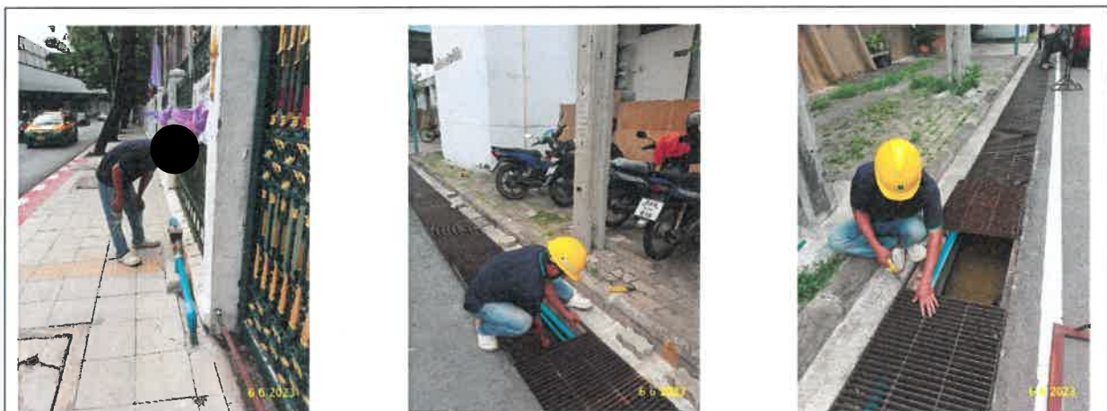
รูปที่ 2-33 แสดงติดตั้งมีเตอร์รับน้ำและระบบท่อประปาเชื่อมต่อกับท่อประปาของสำนักงานประปานครหลวง
