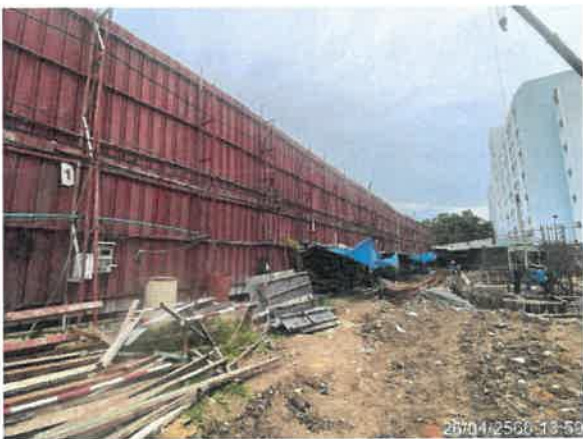
รูปที่ 2-2 แสดงรั้วทึบเมทัลชีท (Metal Sheet) รอบพื้นที่ก่อสร้าง
