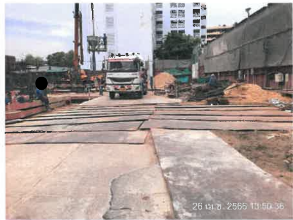
รูปที่ 2-16 แสดงถนนคอนกรีต และแผ่นเหล็กปู บริเวณเส้นทางเข้า-ออกของพื้นที่ก่อสร้าง
