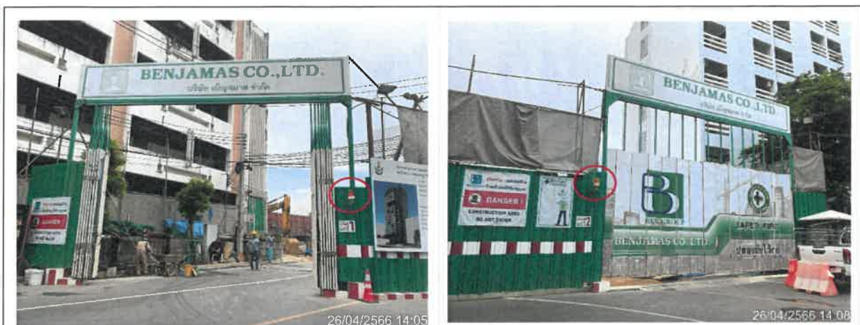
รูปที่ 2-47 แสดงสัญญาณไฟกระพริบ ไว้บริเวณทางเข้า-ออกพื้นที่ก่อสร้าง
