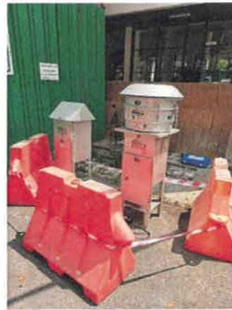
รูปที่ 2-23 แสดงการติดตั้งเครื่องตรวจวัดคุณภาพอากาศ เสียง และความสั่นสะเทือนไว้ในพื้นที่ก่อสร้าง และพื้นที่วิทยาลัยแพทยศาสตร์
