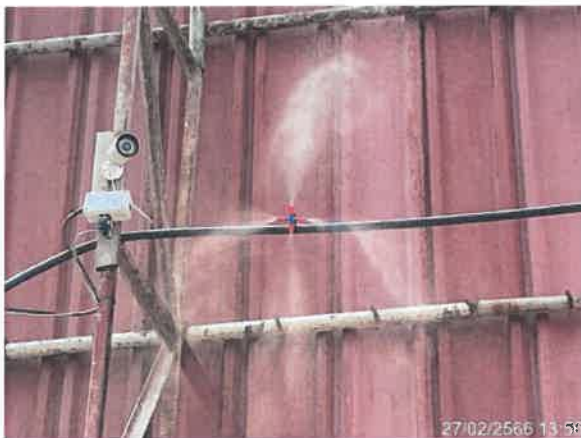
รูปที่ 2-14 แสดงการติดตั้งสปริงเกอร์พ่นน้ำไว้บริเวณโดยรอบรั้วโครงการ
